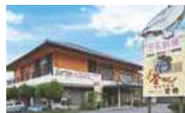
▲大通りに面したゆとりスペースの駐車場
