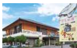
▲大通りに面したゆったりスペースの駐車場
